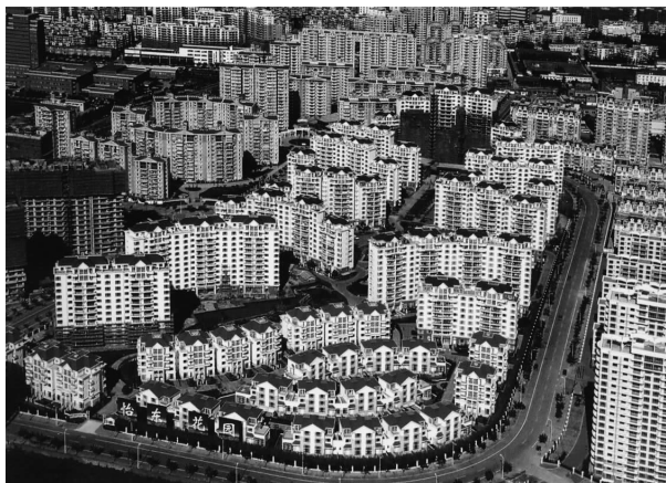
上海浦东新区怡东花园住宅小区
